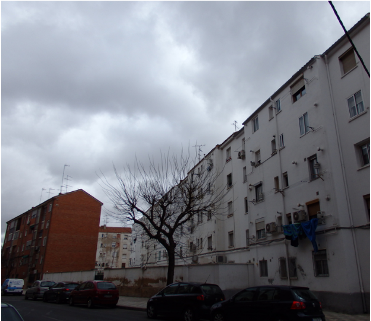
Viviendas “Grupo Lope de Vega” (2019). Fuente: SEFT.
