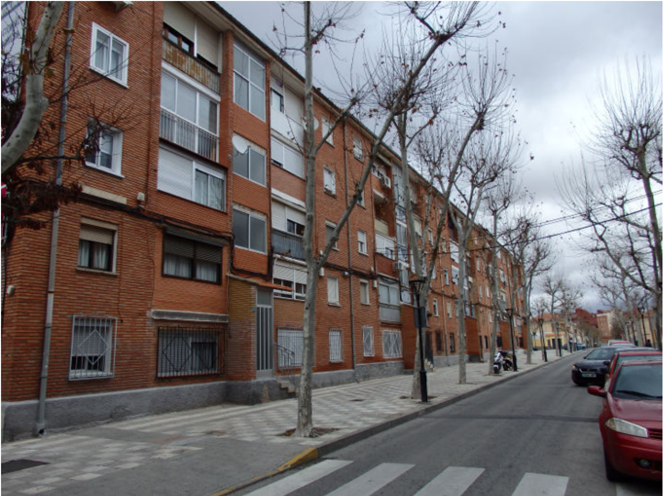
Viviendas “Grupo Lope de Vega” (2019). Fuente: SEFT.
