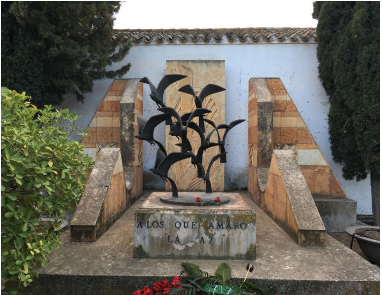
Vista frontal del monumento. La inscripción se encuentra deteriorada por el paso del tiempo (2019). Fuente: SEFT.
